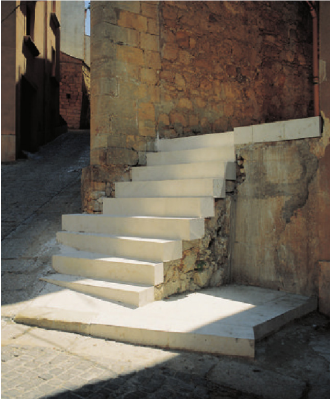
Het herstel van routes door de stad is gedaan met witte steen
