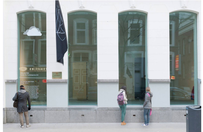
Gevel na de renovatie
