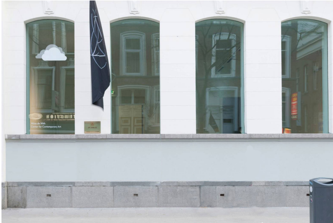
Gevel voor de renovatie
