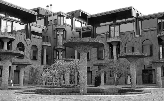
Achteringang voor de renovatie
