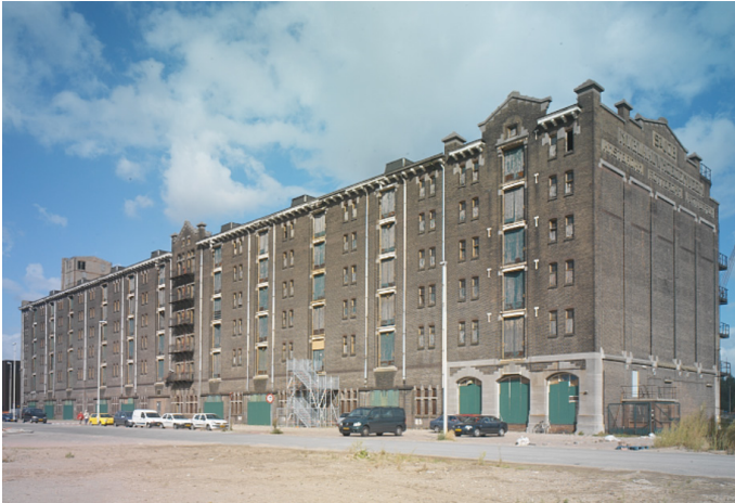
Jobsveem voor de renovatie
