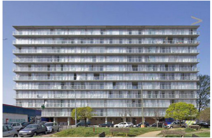
De flat na de renovatie
