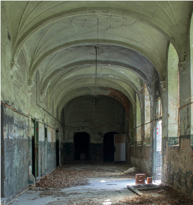
Gang voor de renovatie
